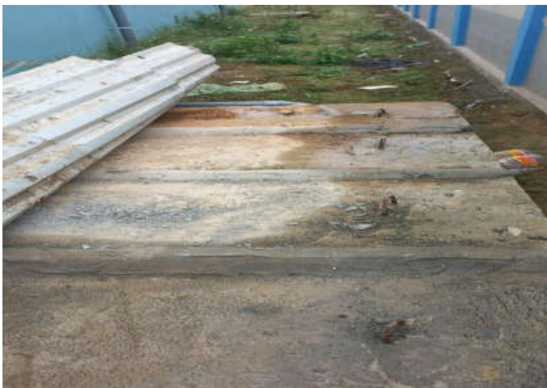
Hình 3.3: Bể tách dầu mỡ tại nhà ăn ca công nhân
